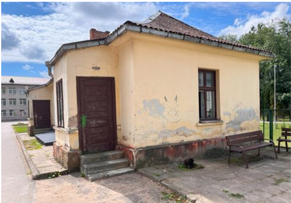
F.6. Šiaurinis pastato fasadas.
