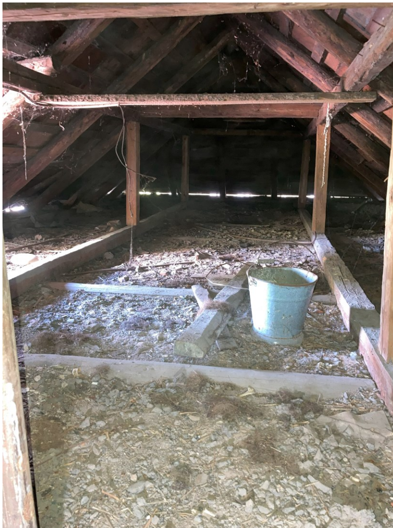
F.11. Pastogės konstrukcija.
