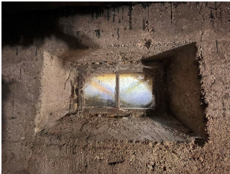
F.17. Rūsio patalpa nr. 8. Švieslangis formuotas iš betono.
