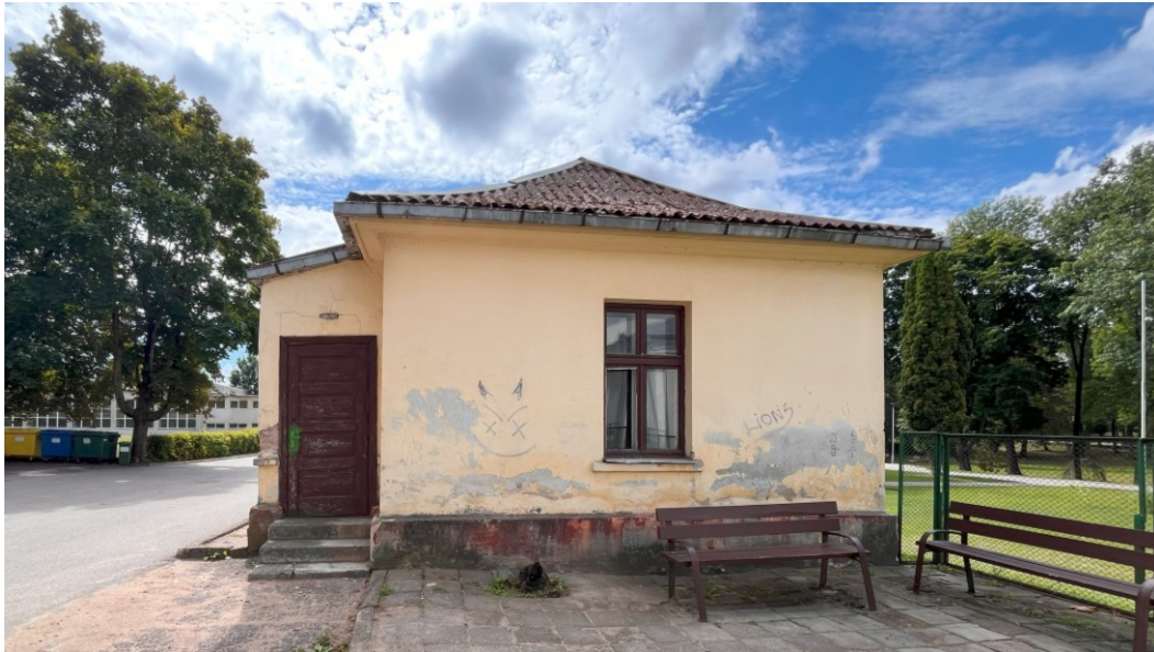
F.10 Šiaurinis pastato fasadas.
