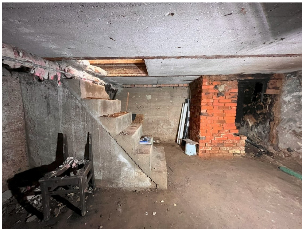
F.21. Rūsio patalpa nr. 8. Šiaurinė siena.
