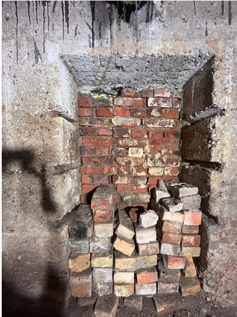
F.16. Rūsio patalpa nr. 8. Niša N1. Nišos dugnas praardytas, užmūrytas viena eile plytų.
