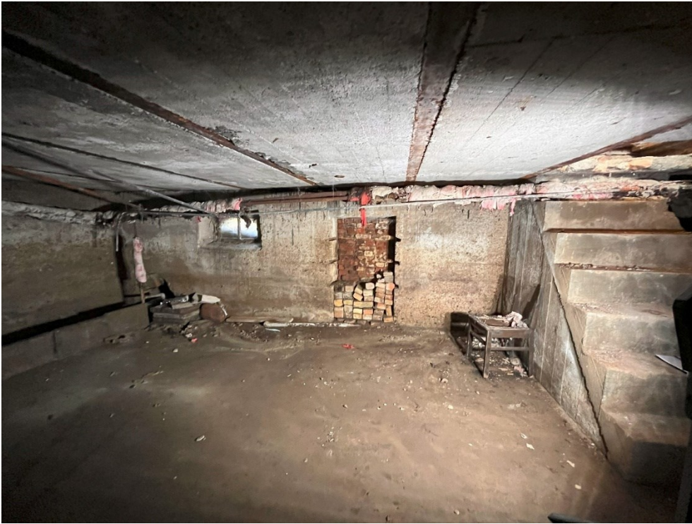
F.14 Rūsio patalpa nr. 8. Vakarīnē siena formuota īs beton.
