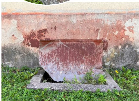
F.8. Rūsio patalpos nr. 9 prieduobė su švieslangiu.
