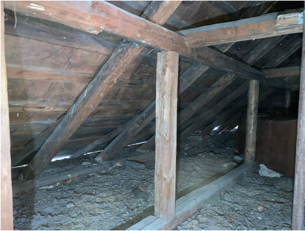
F.12. Pastogės konstrukcija.
